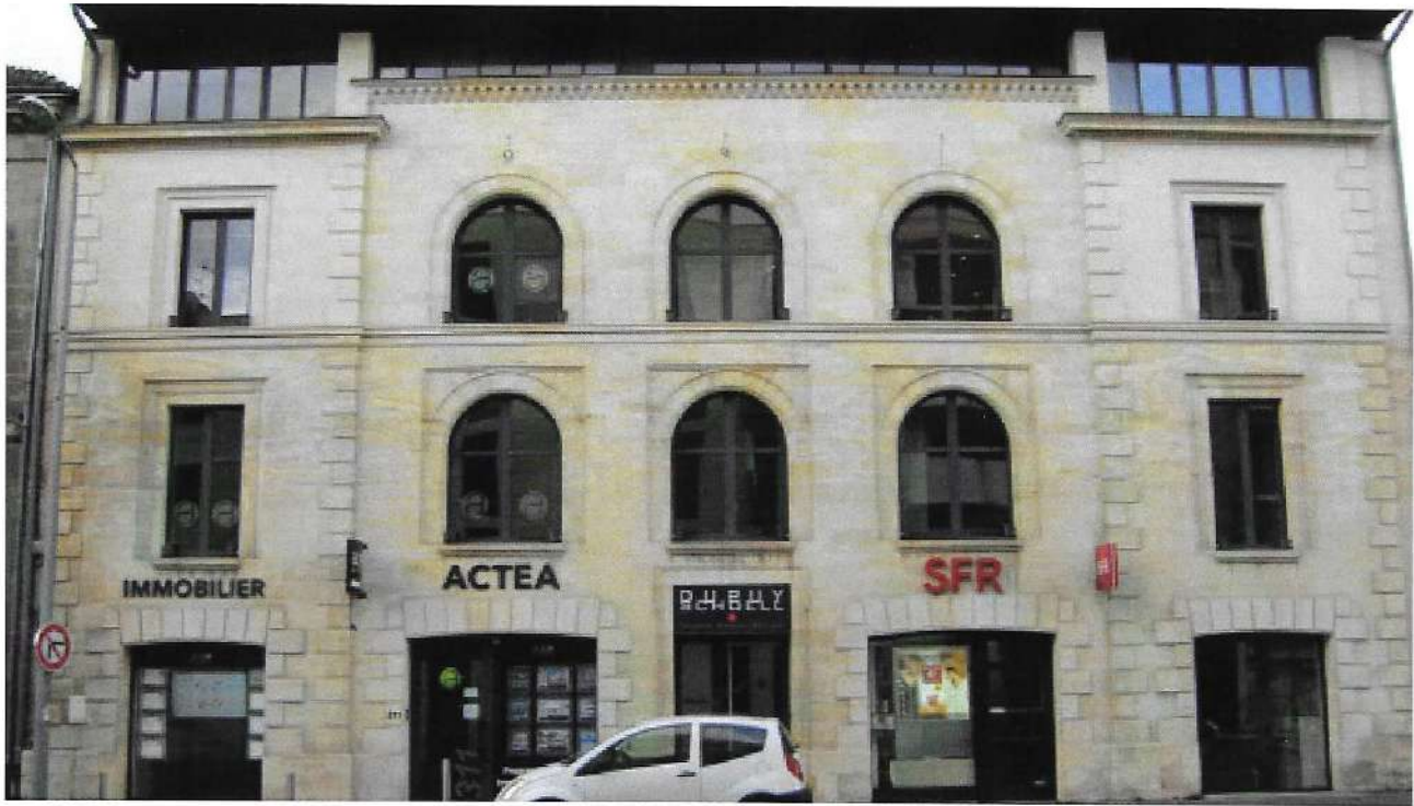
Fig. 6 – l'ancien presbytère en 2019 (Photo M. Bonoron).
